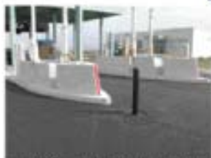
NEXCO 南アルプスIC (料金所防護)
