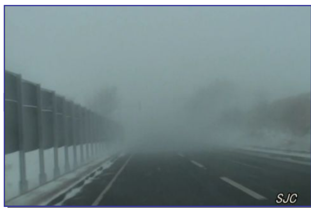
▲防雪柵設置箇所状況
