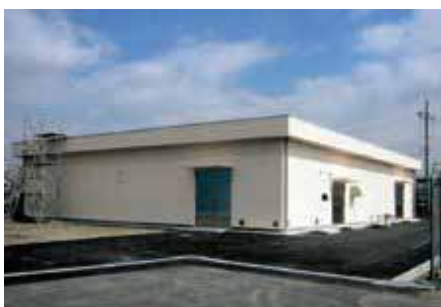
兵庫県 伊丹市 国土交通省大阪空港事務所 第1ASR/SSR・TX局舎 M型×1台
